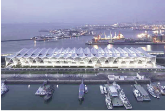
Tổ hợp nhà ga tại Sơn Đông (Trung Quốc) với các kết cấu bằng kim loại xếp lớp độc đáo
